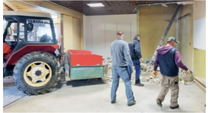
Sanacija gasilskega doma se je začela. (Foto: Arhiv PGD Motovilci)
